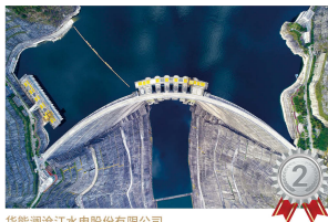
华能澜沧江水电股份有限公司 上帝之眼(华能小湾水电站)(刘水忠摄)
