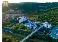
华能煤业有限公司 绿色发展动能(华能李翠煤业矿区) (伏堂荣摄)
