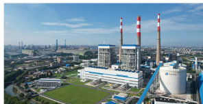
石洞口第一电厂
