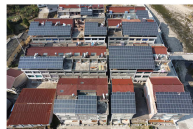
仙居县屋顶分布式光伏项目
