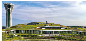
雄安光大生态产业园分布式光伏项目
