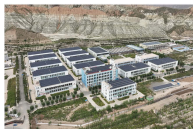
尖扎县低碳分布式光伏项目
